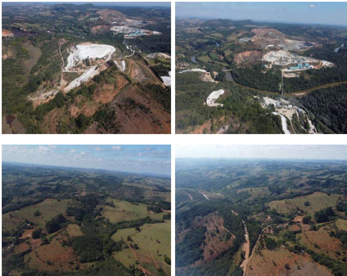
Figura 9.2 - Vista parcial da região da Mina Volta Grande
