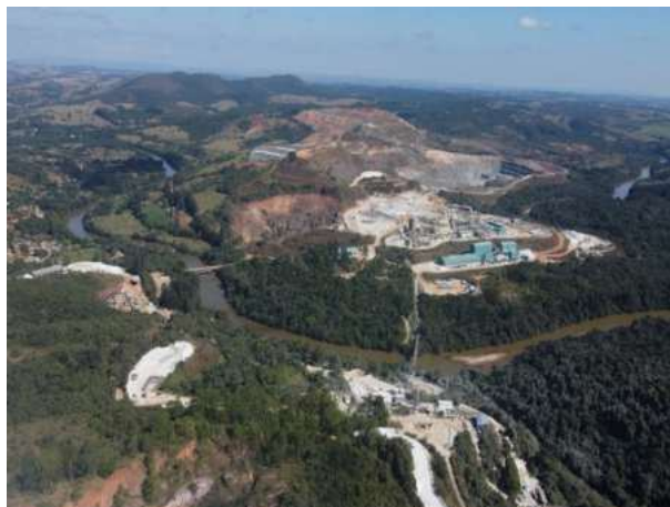
Figura 9.17 - Vista parcial das adjacências da área proposta para o Projeto Ampliação Mina Volta Grande
