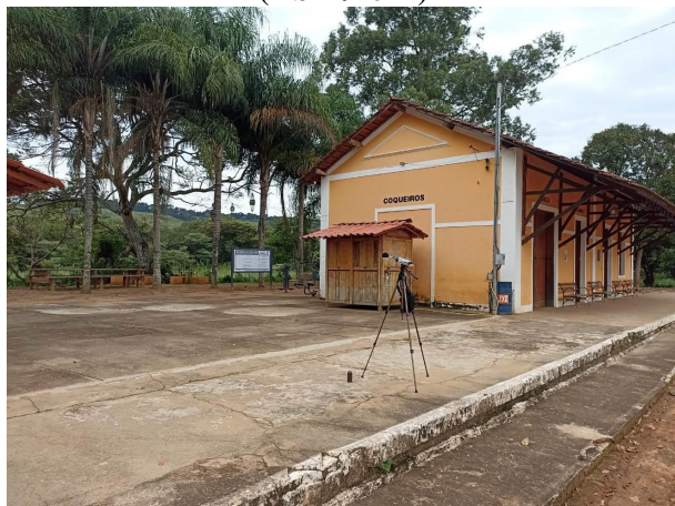
Figura 9.46 - Registro Fotográfico do Ponto de Monitoramento 01 (538365 E/ 7667337 S) (Abril/2024)
