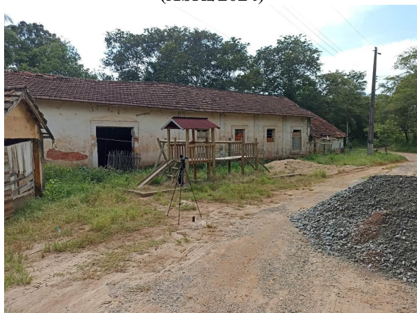
Figura 9.48 - Registro Fotográfico do Ponto de Monitoramento 03 (543475 E/ 7666201 S) (Abril/2024)
