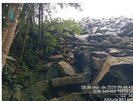
Visão à montante (Campanha Seca)
