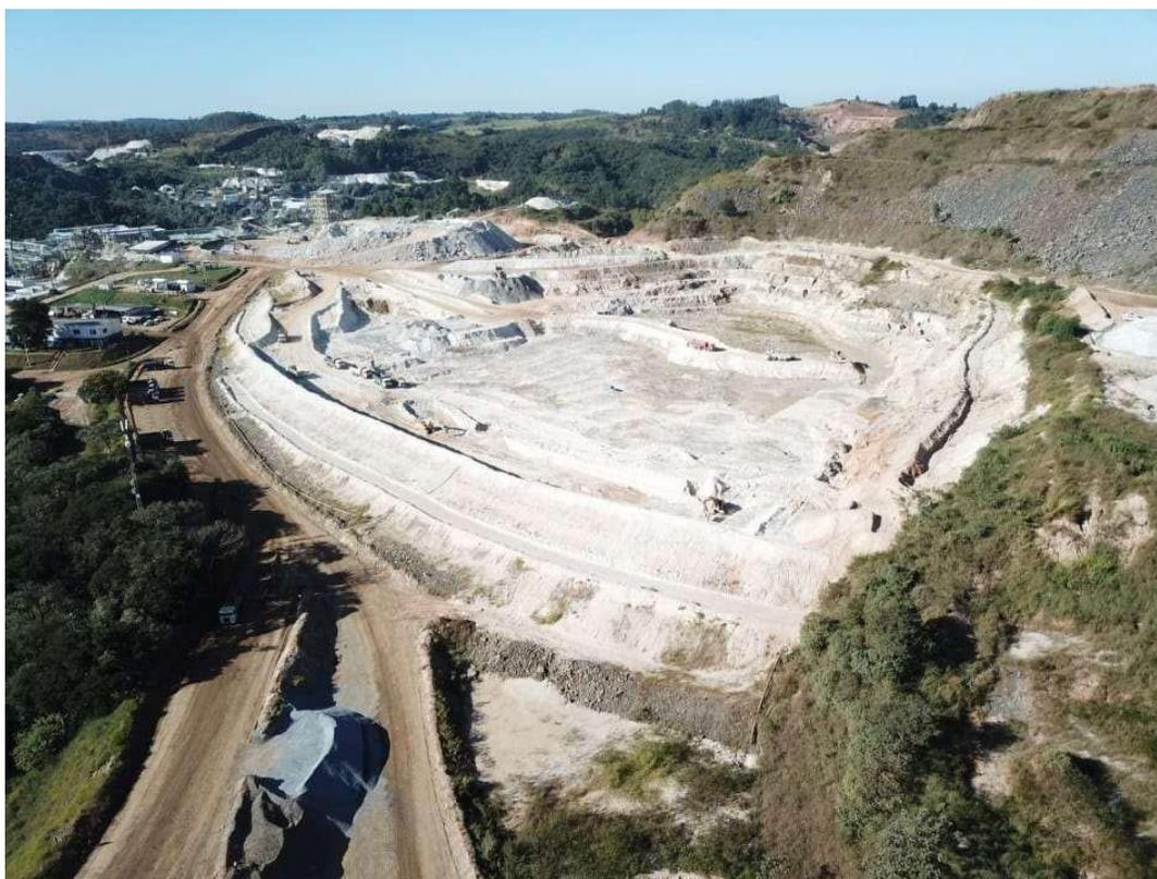
Figura 7.32. Barragem VG2: Fotografia panorâmica da Barragem VG2 mostrando o andamento da remoção das etapas 3, 4, 5 e 6 do processo de descaracterização da barragem (AMG, maio/2023).
