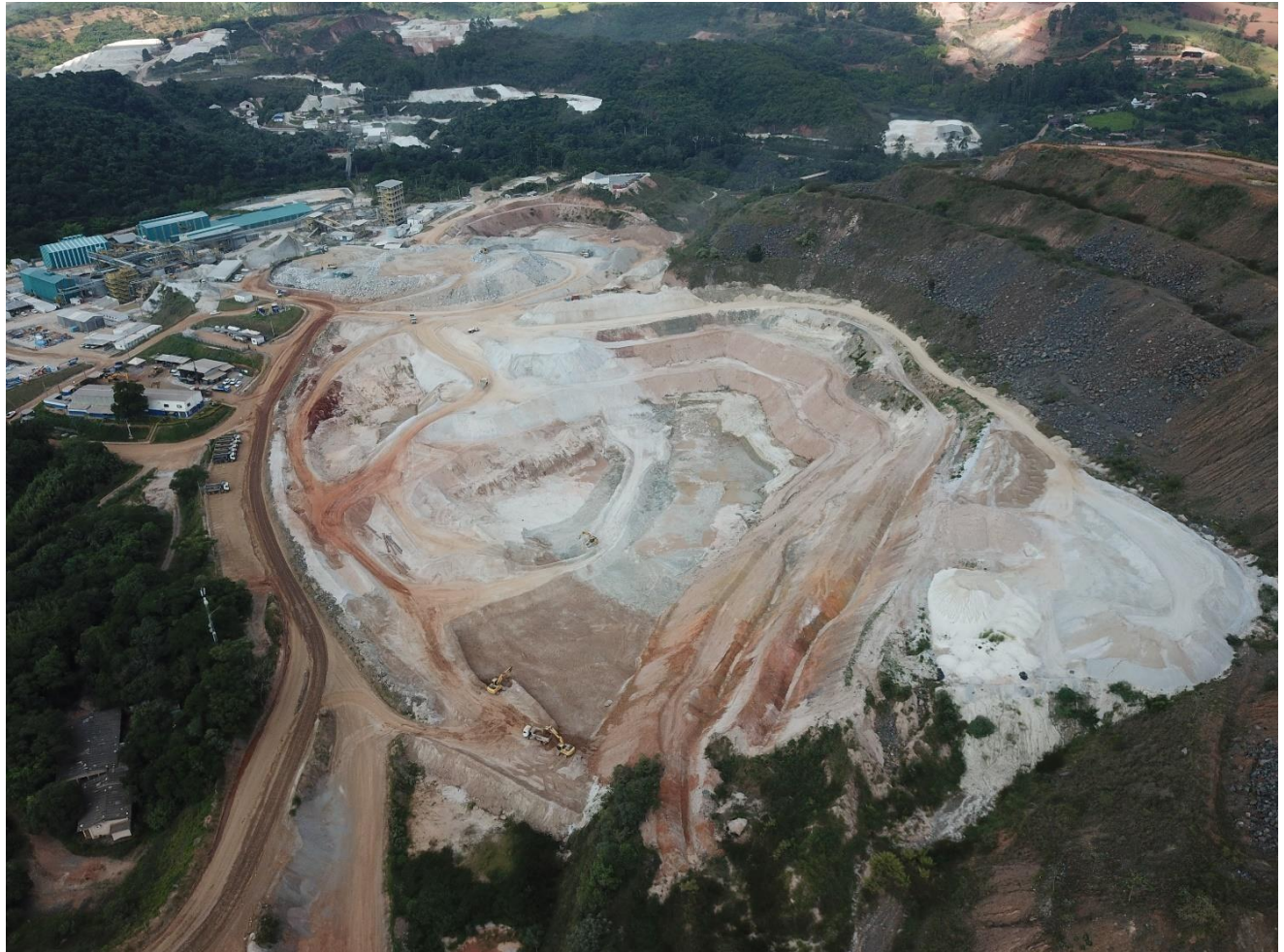
Figura 1 – Vista superior atual da Barragem Volta Grande 2.
