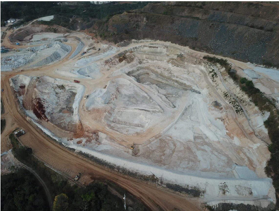
Figura 7.31. Barragem VG2: Fotografia panorâmica da Barragem VG2 mostrando o andamento da remoção das etapas 5, 6, 7 e 8 do processo de descaracterização da barragem (AMG, ago/2023).
