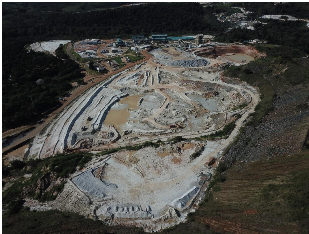
Figura 7.35. Barragem VG2: Fotografia panorâmica da Barragem VG2 mostrando o andamento da remoção das etapas 3, 4 e 5 do processo de descaracterização da barragem (AMG, fev/2023).
