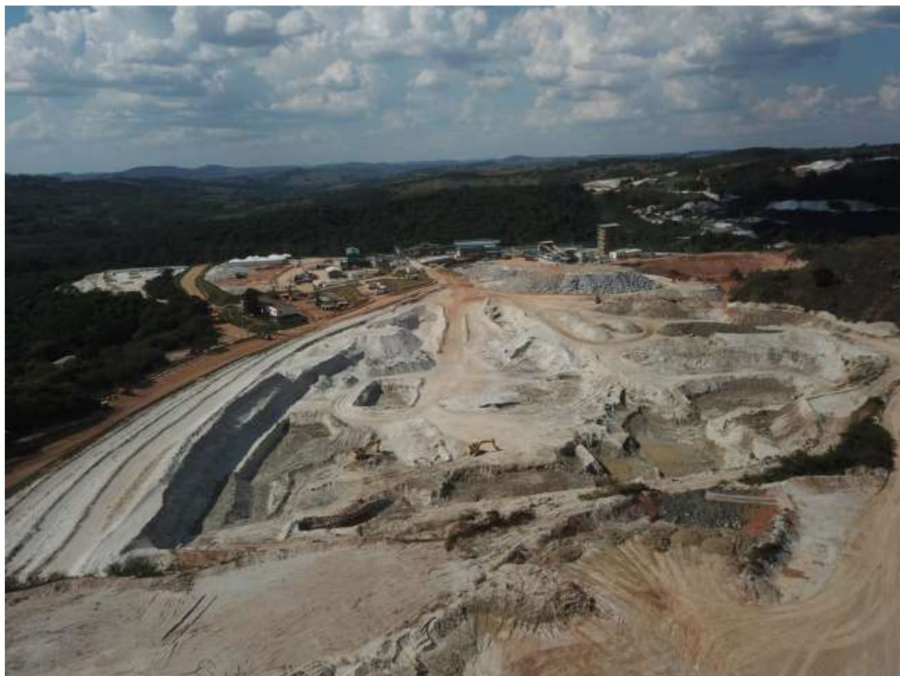
Figura 1 – Vista superior atual da Barragem Volta Grande 2.
