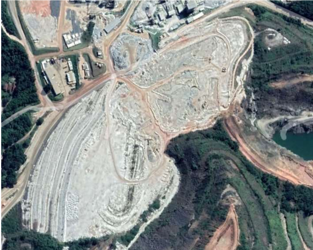
Figura 2 – Barragens Volta Grande 1 e 2 (antes da remoção da Barragem Volta Grande 1).
