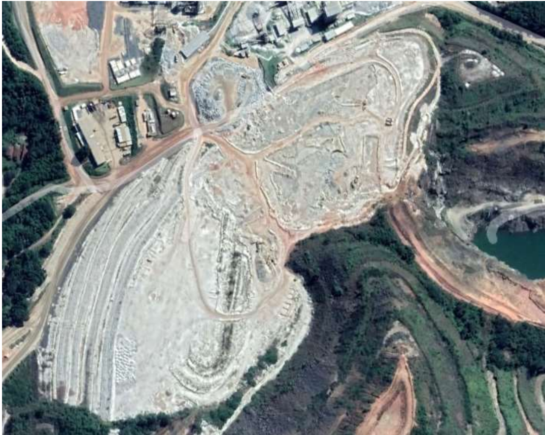
Figura 2 – Barragens Volta Grande 1 e 2 (antes da remoção da Barragem Volta Grande 1).
