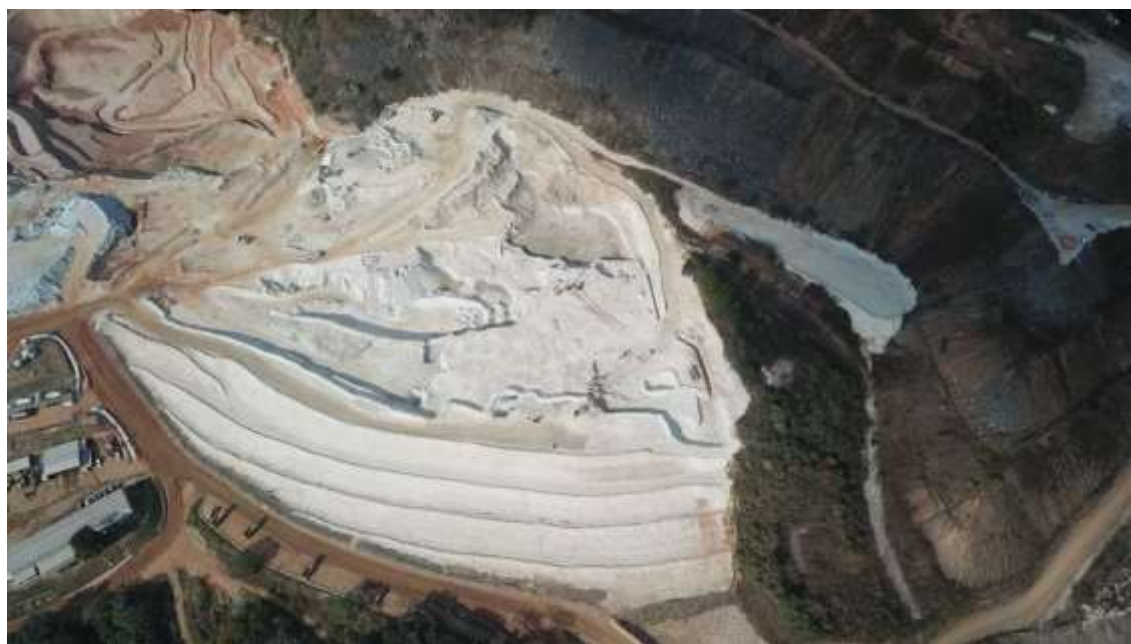
Figura 1 – Vista superior atual da Barragem Volta Grande 2.
